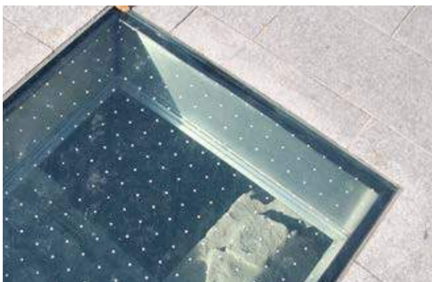
Nedan. Detalj på det tjocka glaset som fungerar utmärkt som markbeläggning på torget..
