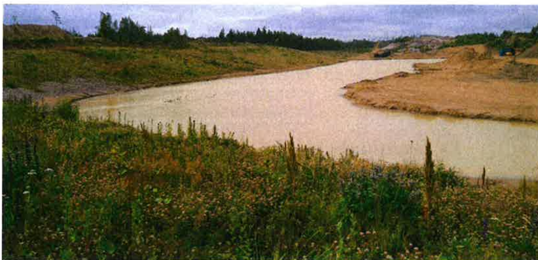
Fig. 1. Bild av pågående täktverksamheter: Längst upp till vänster upplag tillhöriga nyöppnad grustäkt, Dunnebacken 1:2. I mitten pågående utbrytning av grus Dunnebacken 1:3, med täktsjö och med efterbehandlade slänter i förgrund och till vänster i bild. Längst bort i bild skymtar pågående bergtäktsverksamhet på Terås 1:1.
