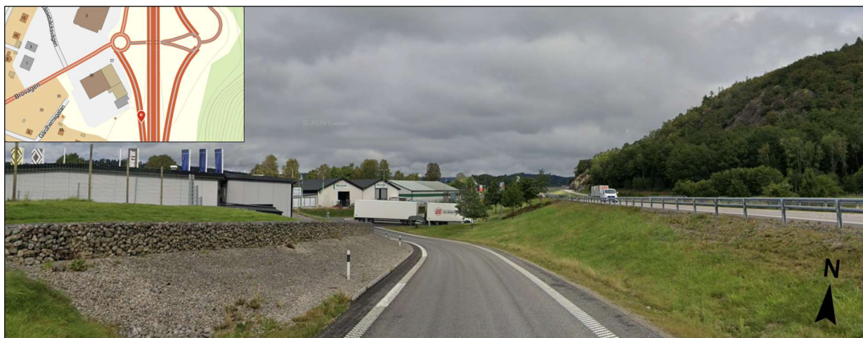
Figur 7-1 – Bild tagen från påfartsrampen till E45 i riktning mot norr. Stendahls bil och gabionmuren är belägna till vänster i bilden och E45 till höger (Google maps, 2026).
