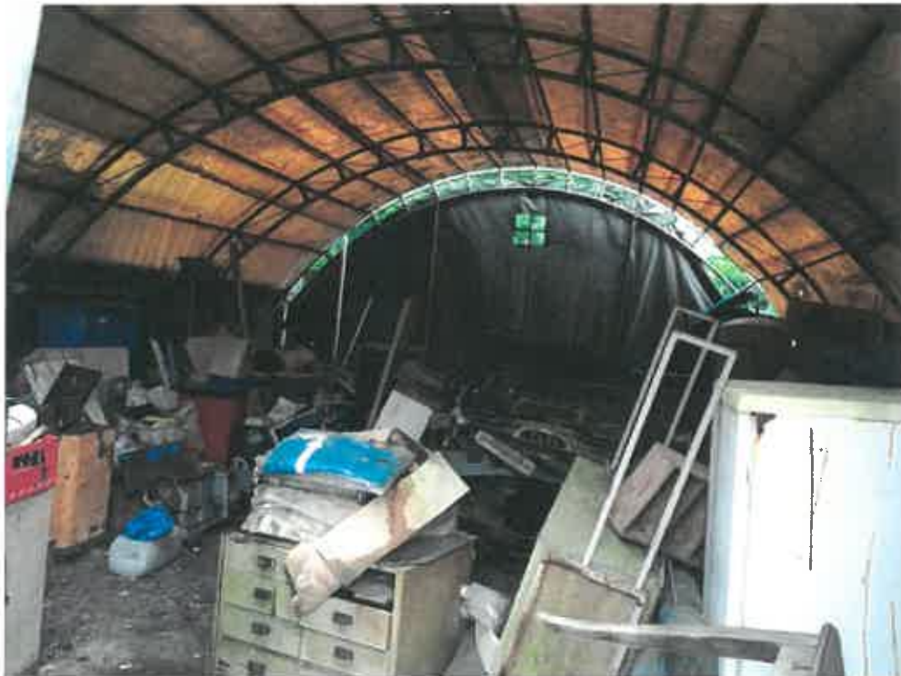
Bild 7, skåp/ möbler - invändigt från förrådstältet
