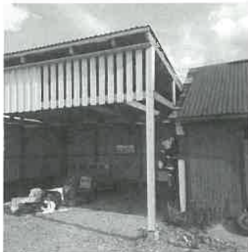
Bild på taket som ändrats till pulpettak.
