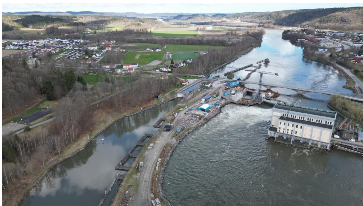
Figur 2 Slussområdet, del av Slottsparken och Ström samt den östra sidan av Lilla Edet sett från söder.
