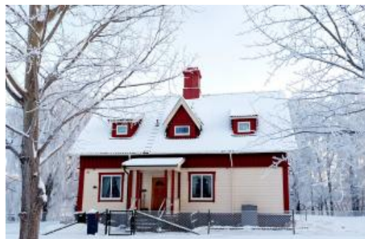
Figur 38 Slussvaktarbostaden: Källa: WSP/Trafikverket.
