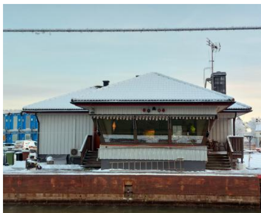
Figur 40 Modern manöverhytt och kanalkontor. Källa: WSP/Trafikverket.
