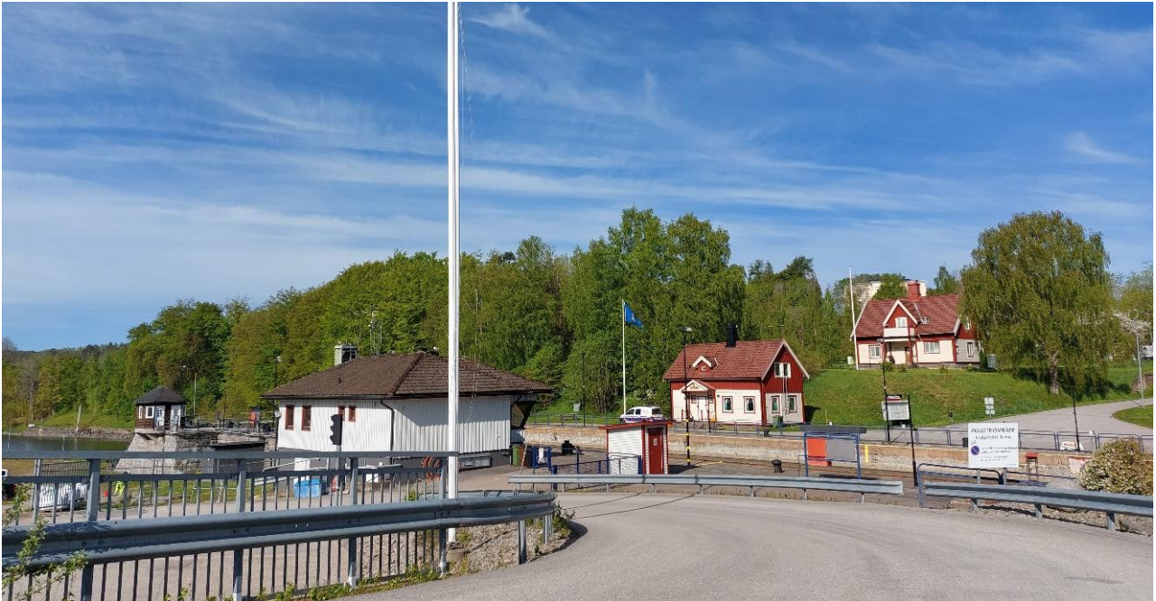
Figur 16 Ströms sluss med tillhörande byggnader. Ströms slott kan anas uppe på höjden bakom slussen.
