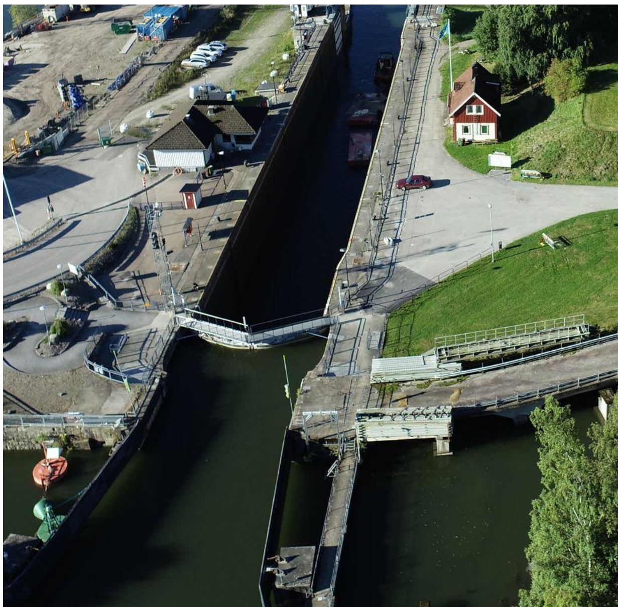
Figur 18 Vy som visar passagen över den befintliga slussen.
