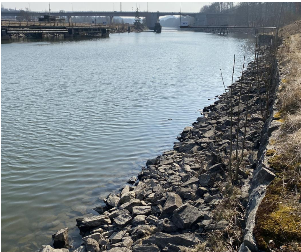
Figur 16. Erosionsskydd nedströms befintlig sluss.
