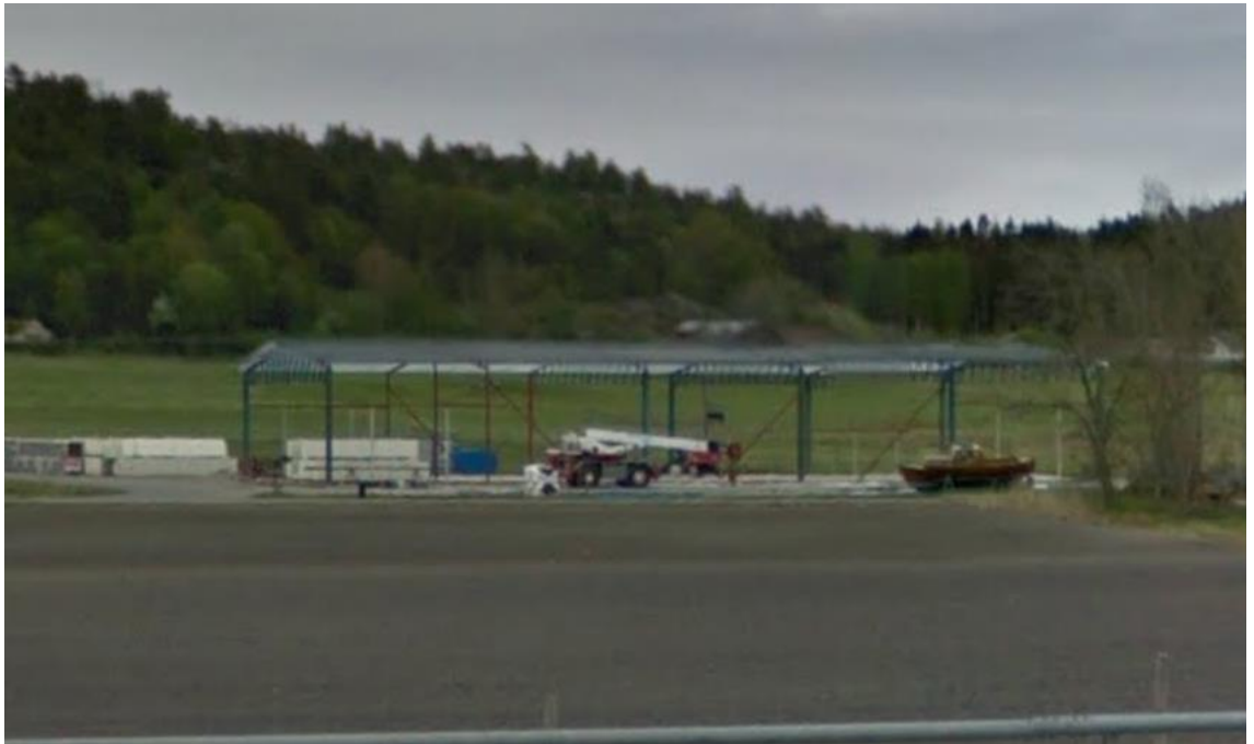
Pågående byggnation, Google Maps maj 2016
