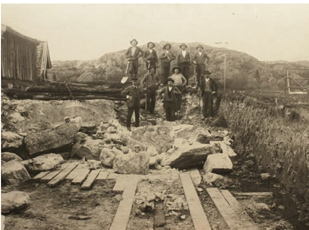
Vid sprängningar för industrispåret vid varvsområdet upptäcktes lämningar av St Olofs kyrka och kyrkogården. Foto från Lödöse Museum.
