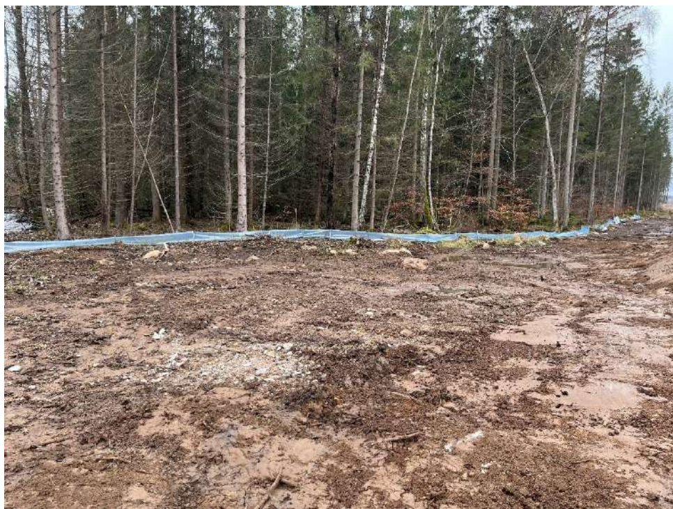
Figur 24. Exempel på barriär i plast vid utbyggnad av väg E22 mellan Lösen-Jämjö i Blekinge. Foto från februari år 2024.
