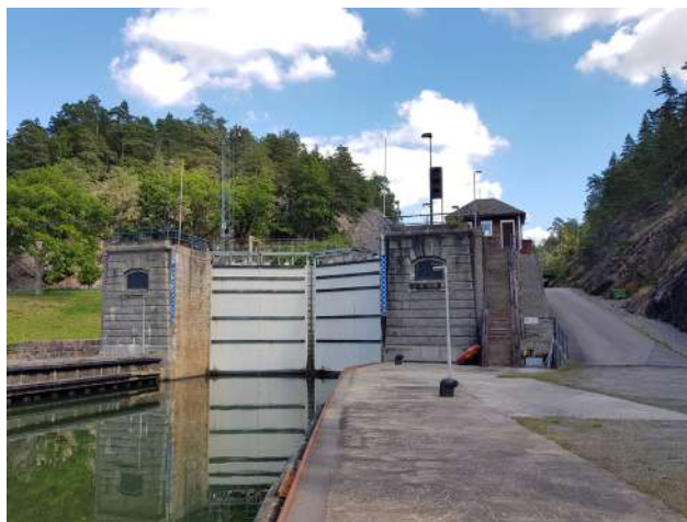
Figur 177 Den nedersta, sluss 6, av slussarna från 1916.
