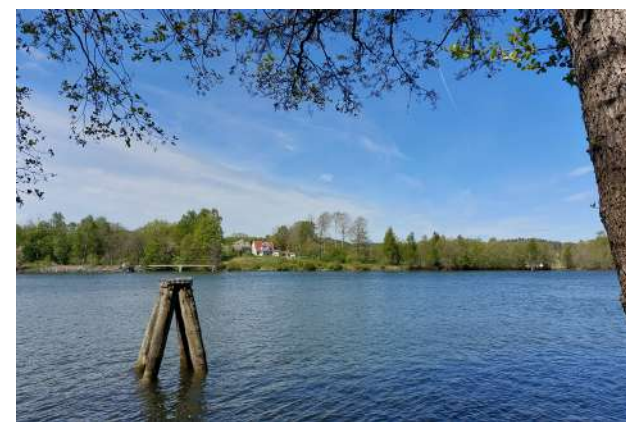
Figur 212 Uppströms slussen, vy över den västra stranden.
