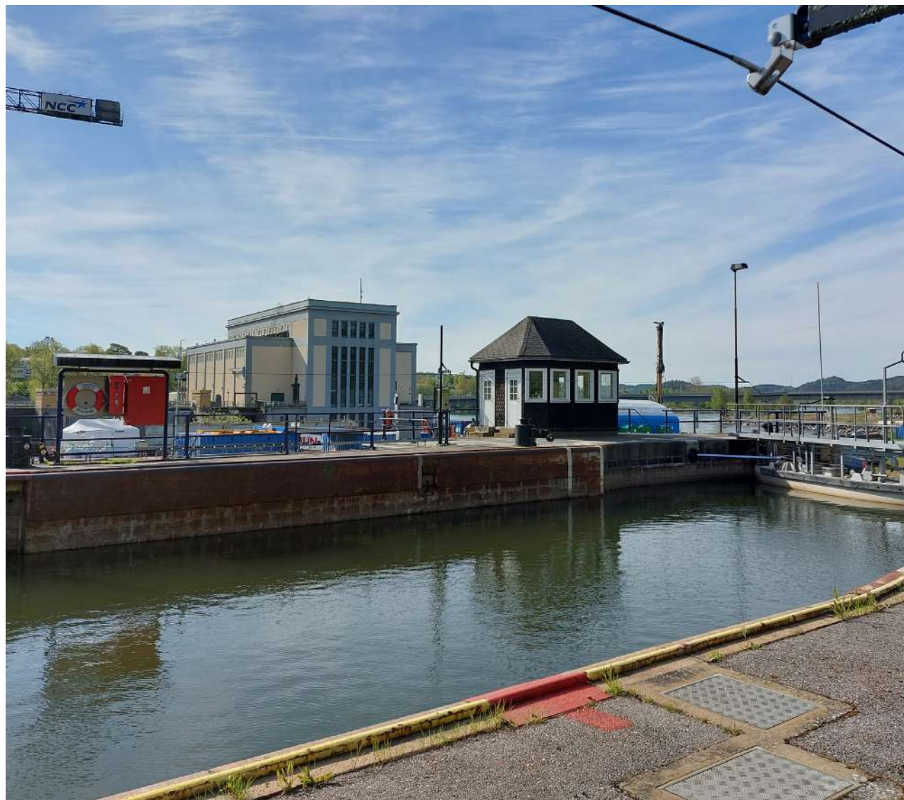
Figur 244 Manöverhytten från 1916 är en typbyggnad som återfinns i både Trollhättan och i Vänersborg. I bakgrunden syns Vattenfalls kraftverksbyggnad från år 1926.
