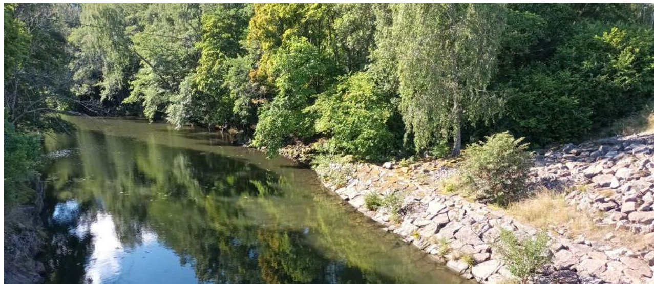
Figur 61 En del av 1840-talets kanal tillhörande Bommens sluss. Strandskoningen lades troligen dit under 1916 års slussbygge.
