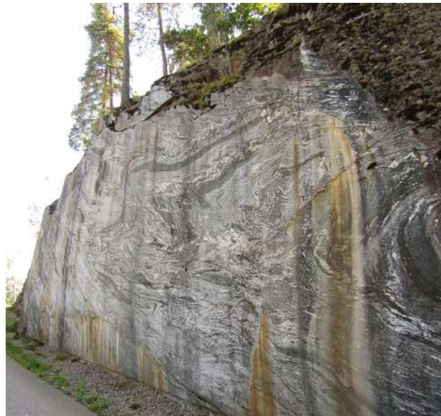
Figur 109 Bergsskärning söder om sluss 3-6 från 1916.
