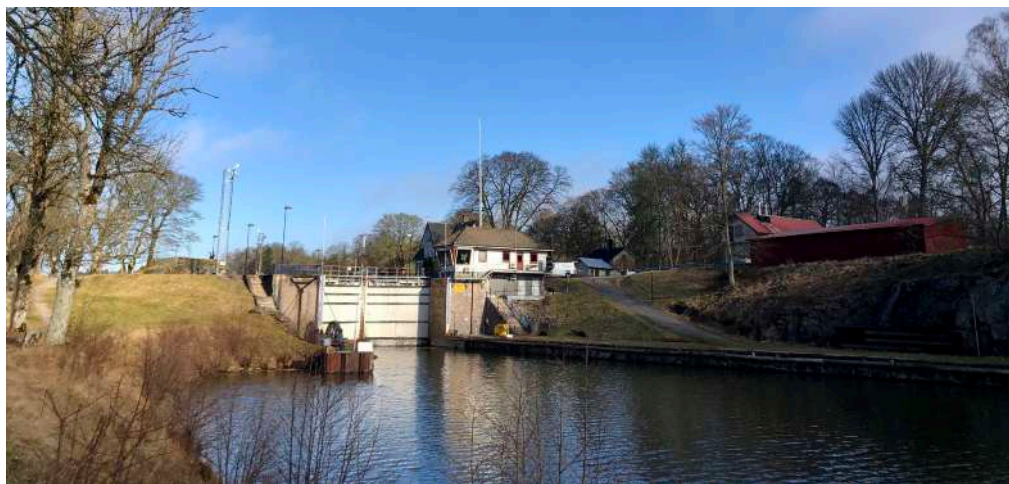
Figur 1 Sluss med stängda slussportar i Vänersborg. Byggnaden till höger om slussen i bild är manöverhytt.
