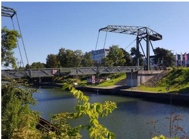
Figur 125 Olidebron är en av få passager över Bergkanalen. Bron kommer oavsett alternativ nord eller syd att behöva byggas om med full bärighet.
