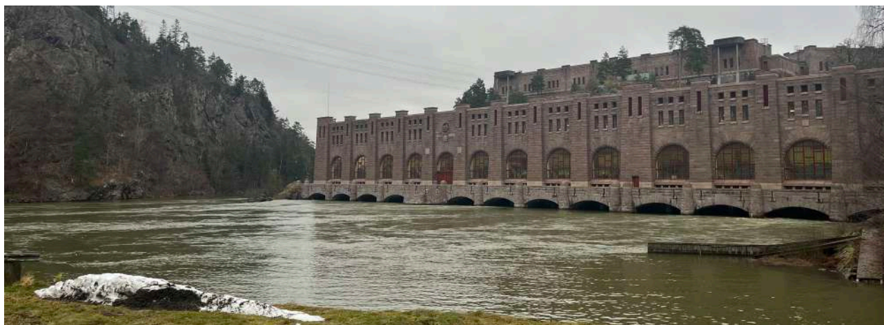
Figur 132 Olidans kraftstation är belägen vid Göta älv. Till vänster i bild syns Älvrummets naturreservat.
