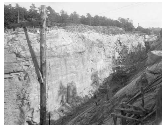
Figur 12 Bild från 1913 som visar hur ett 47 meter högt bergsparti i Trollhättan har sprängts bort för att göra plats åt dagens slussstappa. Sjöfartsverket.
