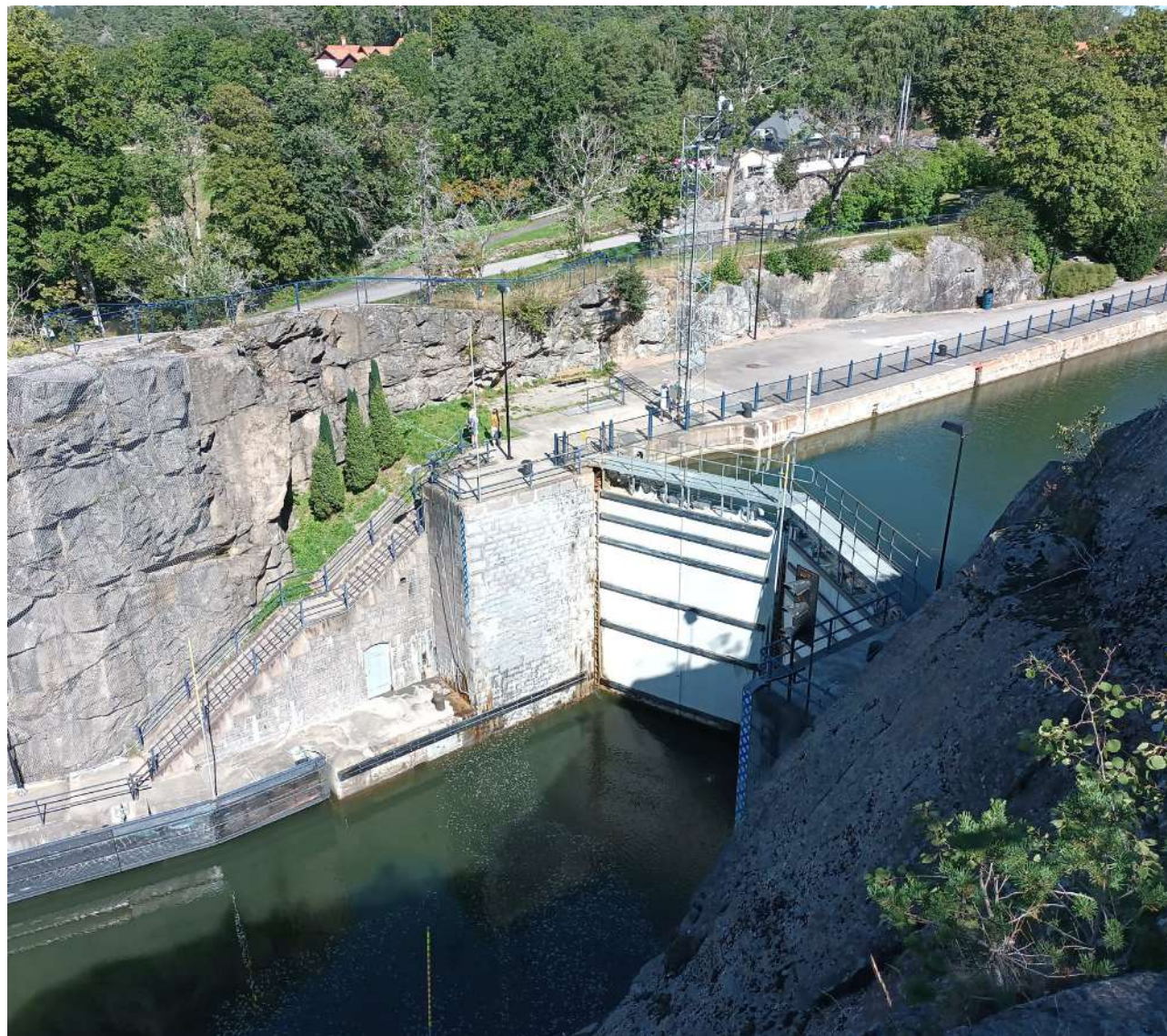
Figur 178 Slussen i Trollhättan omges av höga bergsskärningar.
