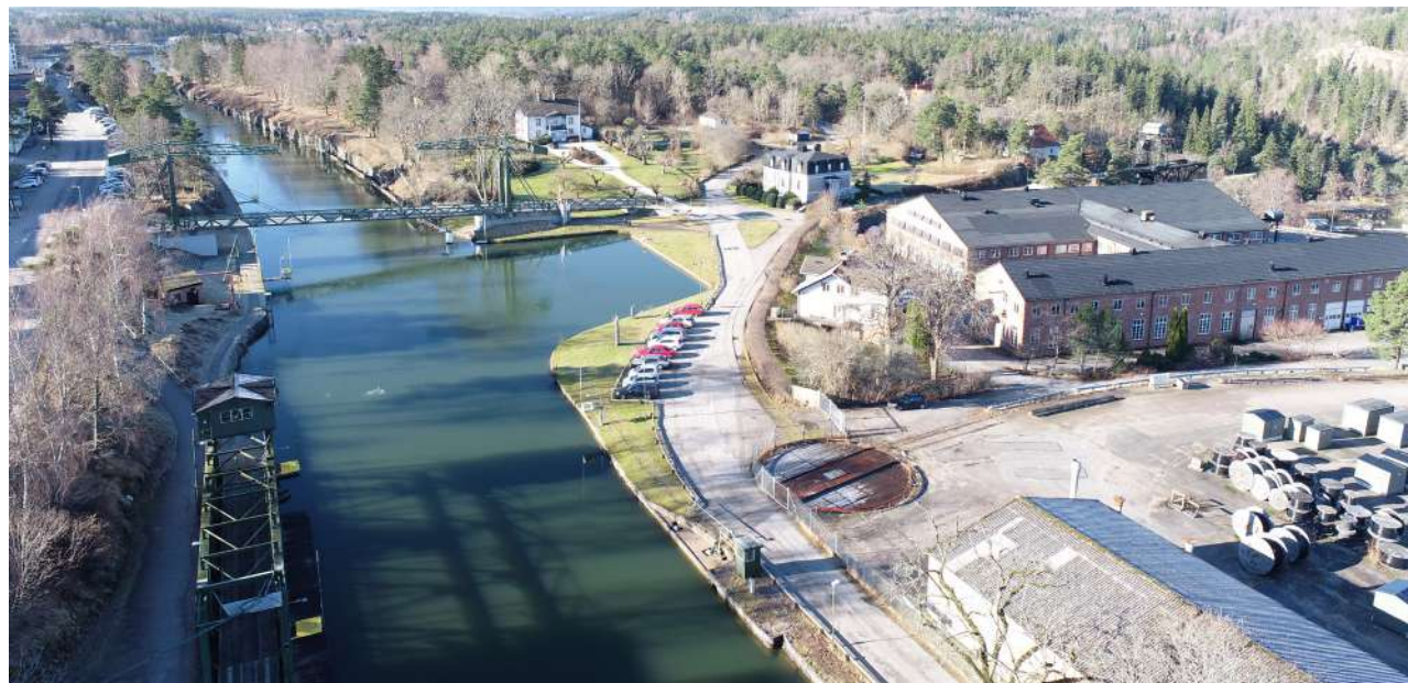
Figur 137 Bergkanalen med det norra industriområdet till höger i bild.
