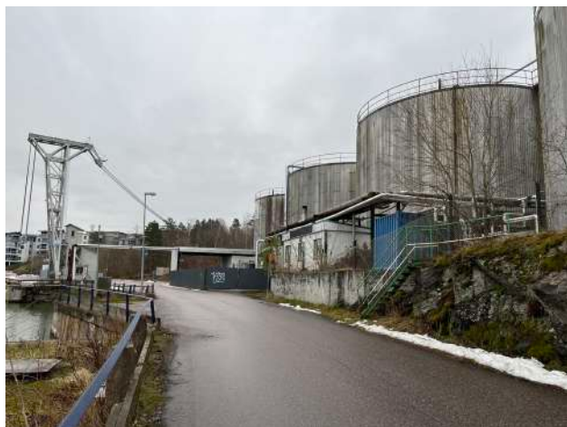
Figur 173 Cisterner och Rysskranen på södra stranden.
