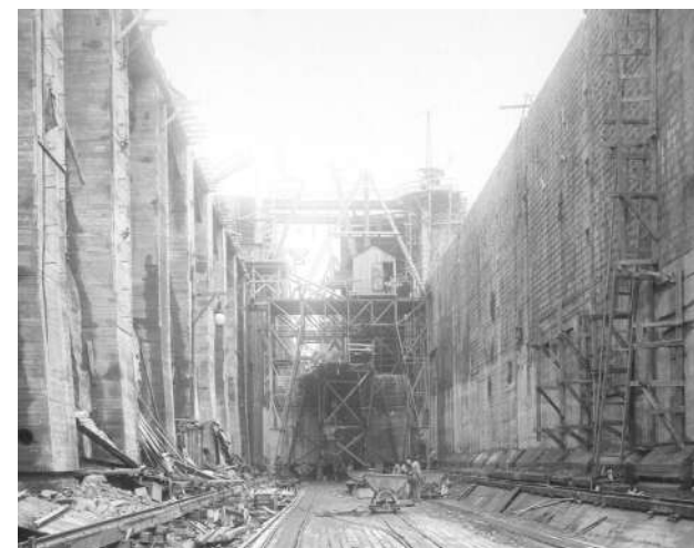
Figur 13 Två år senare, 1915, har den monumentala slusskammaren tagit form efter omfattande betong- och murningsarbeten. Sjöfartsverket.
