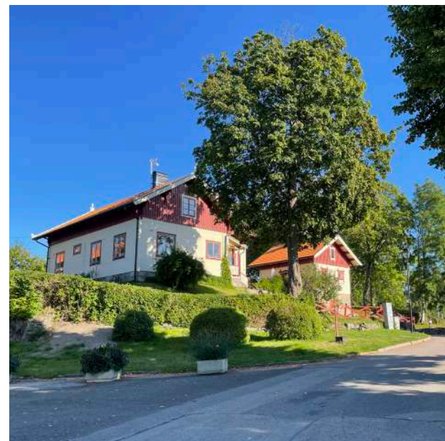
Figur 167 Byggnader knutna till slussverksamheten och dess anställda från sent 1800-tal och tidigt 1900-tal.
